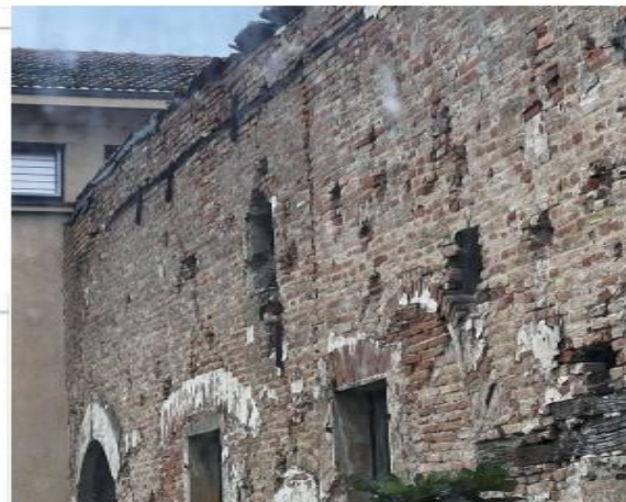
M3. ROTTURA A FLESSIONE DELLE PARETI
