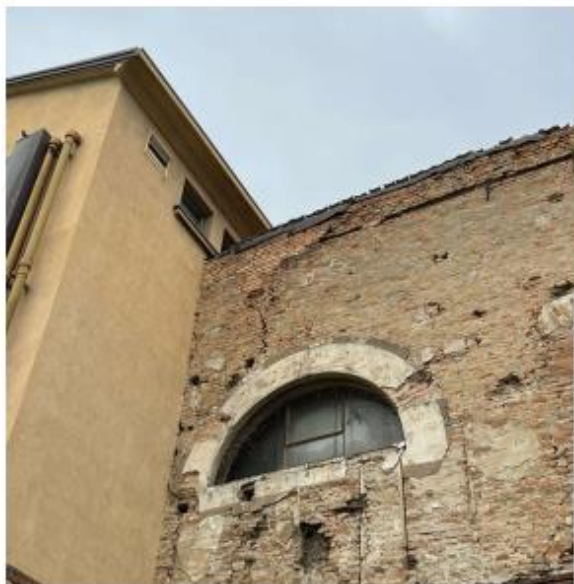
M26. DANNO PER IRREGOLARITA' DI FORMA
