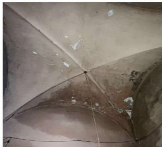
M12. DANNO ALLE VOLTE PER ROTAZIONE DELLE IMPOSTE
